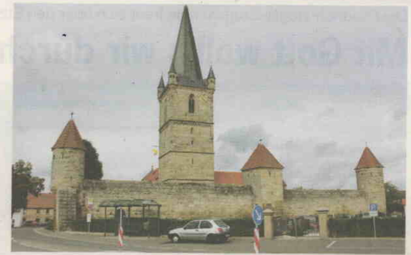
Außenansicht der renovierten Wehrkirche.
