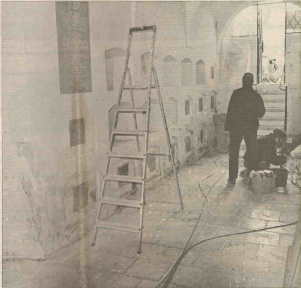
Damit sich die Gruft der Dießener Augustiner-Chorherren zum Tag des offenen Denkmals am 10. September passabel präsentiert, wird sie derzeit restauriert. Bild: Karlheinz Schuh
