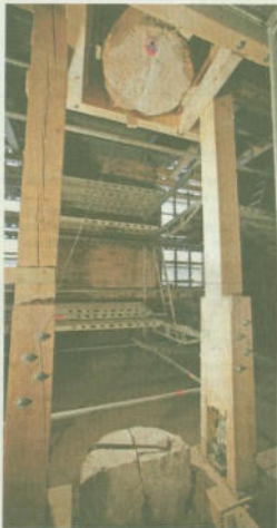
Diese Säule am Seitenschiff wird sozusagen am offenen Herzen operiert: Ihre tragenden Steine, vom Feuer porös gemacht, werden ersetzt.
