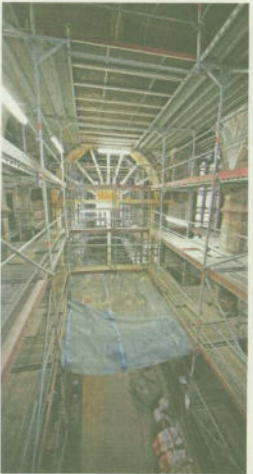
Gerüste, wohin das Auge reicht. St. Martha, eigentlich ein stilles Kleinod unter den Altstadtkirchen, ist von Baulärm erfüllt.
