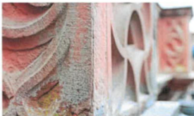
Schalenbildung: Wenn sich Sandsteinplatten ablösen, müssen sie aufwendig gesichert werden.
