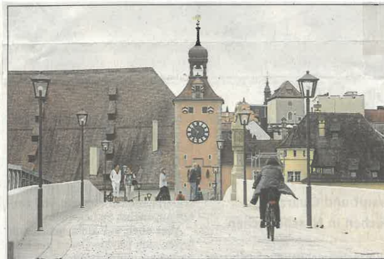
Radler und Fußgänger unterwegs auf der sanierten Brücke.
