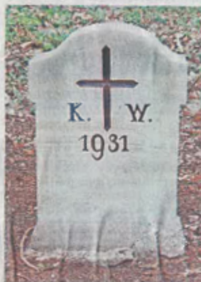
Die Absandungen auf dem Gedenkstein wurden beseitigt und die Inschrift auf dem Gedenkstein erneuert.
