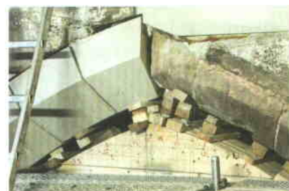
Die Wiederherstellung der oberen Rundbögen in Kombination von Original- und Neusubstanz gestaltete sich für die Spezialisten des Bamberger Natursteinwerks besonders anspruchsvoll. Foto: Georg Rieger
