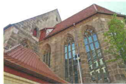
Bescheiden, unspektakulär und neu bedacht präsentiert sich St. Martha heute, hier der südliche Chor. Spuren des Wiederaufbaus zeigt die Giebelwand; im Vordergrund das Dach der Sakristei. Foto: Siegfried Galter
