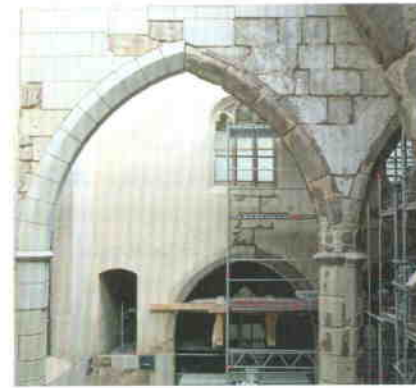
Diese Ansicht, mit bereits fertiggestellter Musterfläche im nordwestlichen Seitenschiff, vereint fast alle rekonstruktiven und restauratorischen Stadien in verschiedenen Vollendungsstufen. Foto: Georg Rieger
