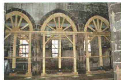
Zur Sicherung der Rundbögen im Langhaus wurden hölzerne Bogengerüste eingepasst. Foto: mbi
