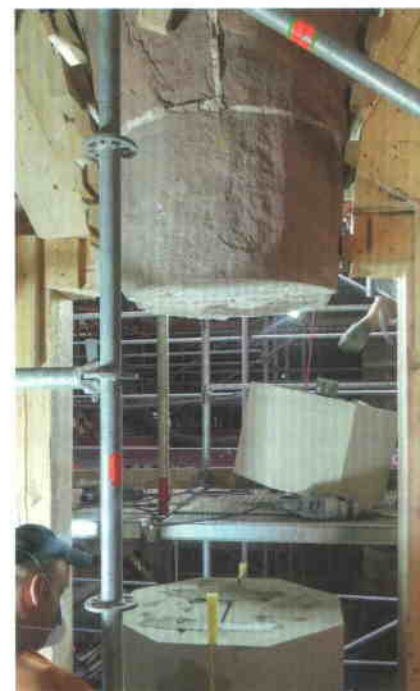
Zum Austausch fundamental geschädigter Säulentrommeln wurde der obere Bereich der betreffenden Bogensäulen mit einer Lehrgerüst-Stützkonstruktion abgefangen. Foto: Georg Rieger
