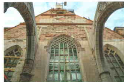
Innenansicht der westlichen Giebelwand, bereits mit neuem Maßwerkfenster und mittleren Längsbögen mit neu verbauter Steinsubstanz; oberhalb der Orgelepore waren die Schäden aufgrund der großen Hitzeeinwirkung besonders stark, ca. ein Drittel des Steinmaterials musste hier ersetzt bzw. ergänzt werden. Foto: Georg Rieger
