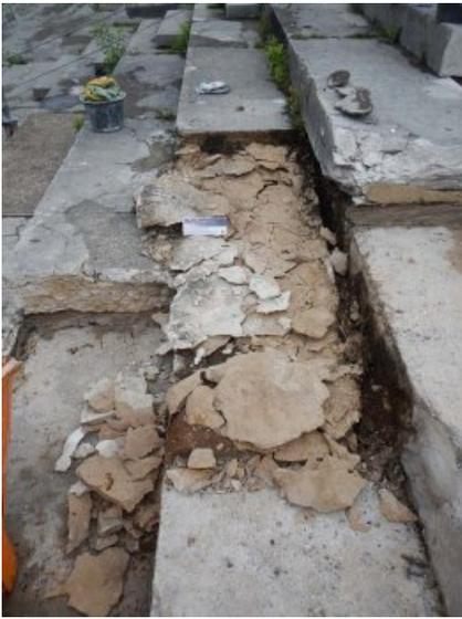
Beim Abbau defekter und stark entfestigter Stufen.
