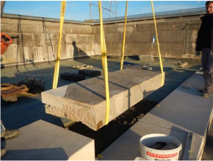
Beim Wiederversetzen einer Stufe.
