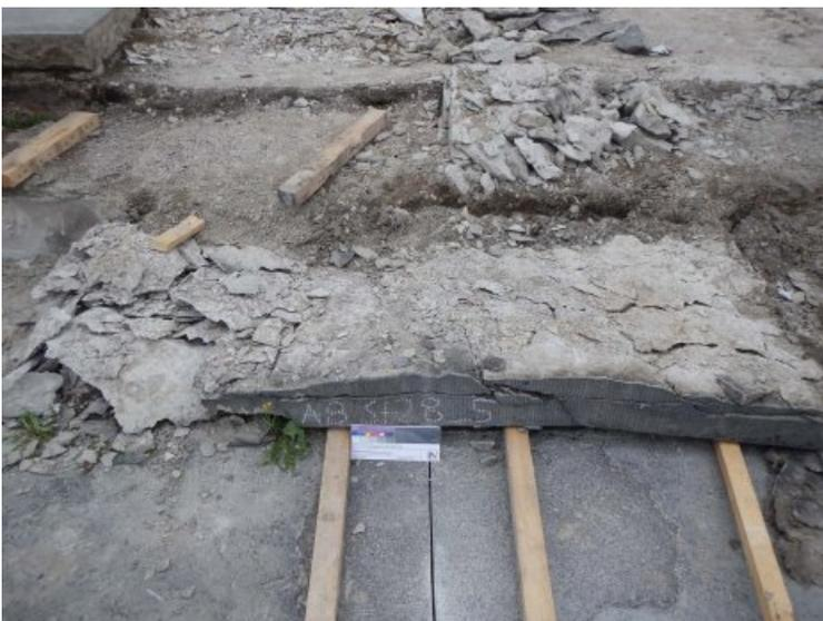
Beim Ausbau defekter und stark reduzierter Stufen und Bodenplatten.
