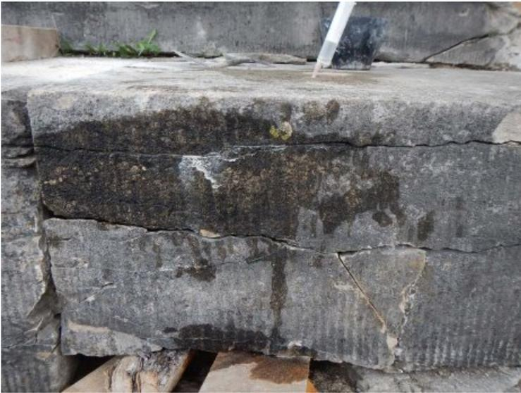
Beim Injizieren der Risse wurde ersichtlich, dass die Risse miteinander verbunden sind, da das an der Trittläche eingebrachte Injektionsgut an der Stirnfläche der Stufe austrat.
