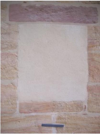
Nach dem Verputzen ehemaliger Mauerwerksöffnungen und Schließen der Fugen sowie Konservieren verbleibender Metallteile.
