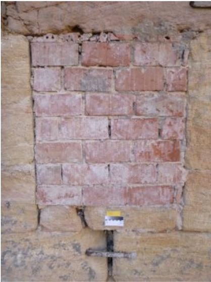
Die Mauerwerksöffnung wurde zugemauert.
