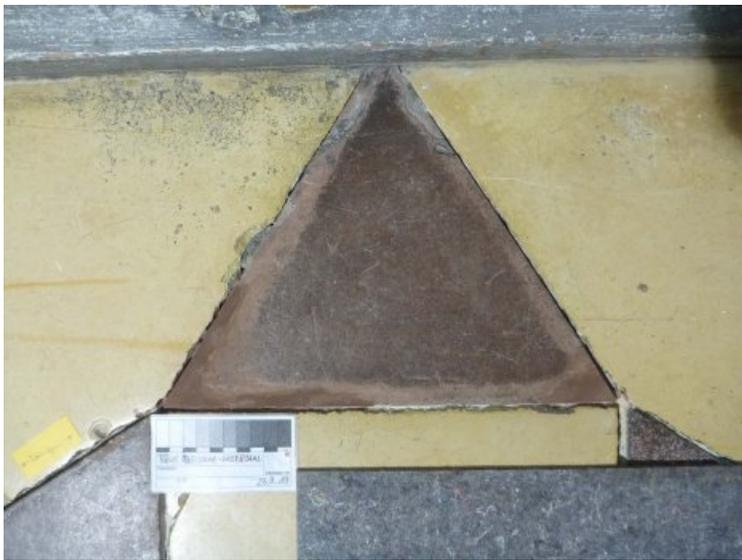
Zwischenzustand: Zur konstruktiven Ertüchtigung der Bauteiloberflächen wurden Fehlstellen in den Platten aus Rotem Mainsandstein ergänzt.
