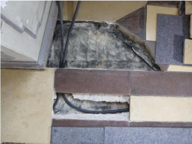
Detail zur Zuarbeit TGA: Vornehmlich die Solhofer Platten wurden ausgebaut, der Setzmörtel der Platten entfernt und die Wellrohre unter die Mainsandsteinplatten hindurch verlegt.
