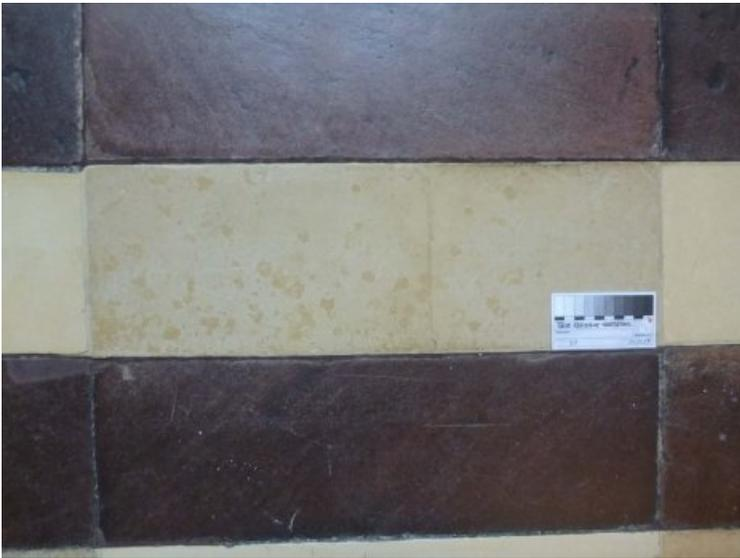
Nachzustand: Die Platte wurde neu versetzt, der Riss und die Fugen verschlossen.
