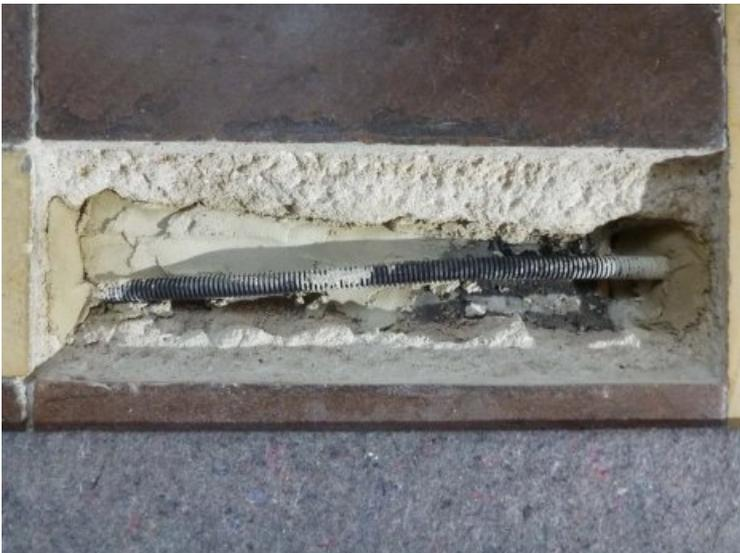
Die verbliebenen Öffnungen und neu verlegte Wellrohre wurden mit neuem Setzmörtel verfüllt.
