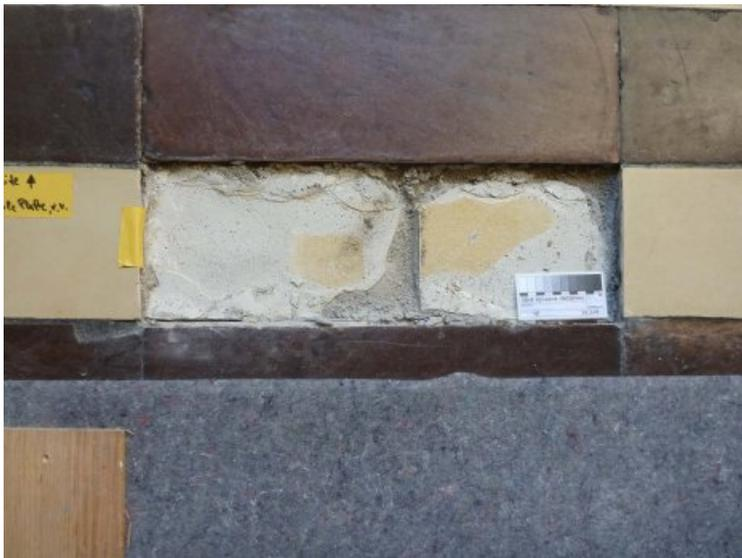
Nach dem Ausbau der Platte kam der zementär gebundene Setzmörtel zum Vorschein.
