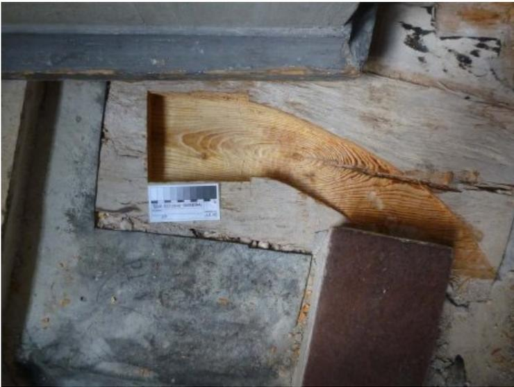
Nach dem Ausbau der Steinplatten und dem Durchstoßen und Beräumen der Setzmörtelschicht wurden die Holzdielen ebenfalls geöffnet/ausgestemmt um die Bodensteckdosen versenkt einsetzen zu können.
