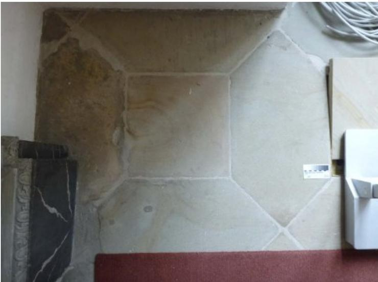
Nachzustand: Die Platten wurden aus- und wieder eingebaut, Wellrohre verlegt und abschließend die Fugen verschlossen.
