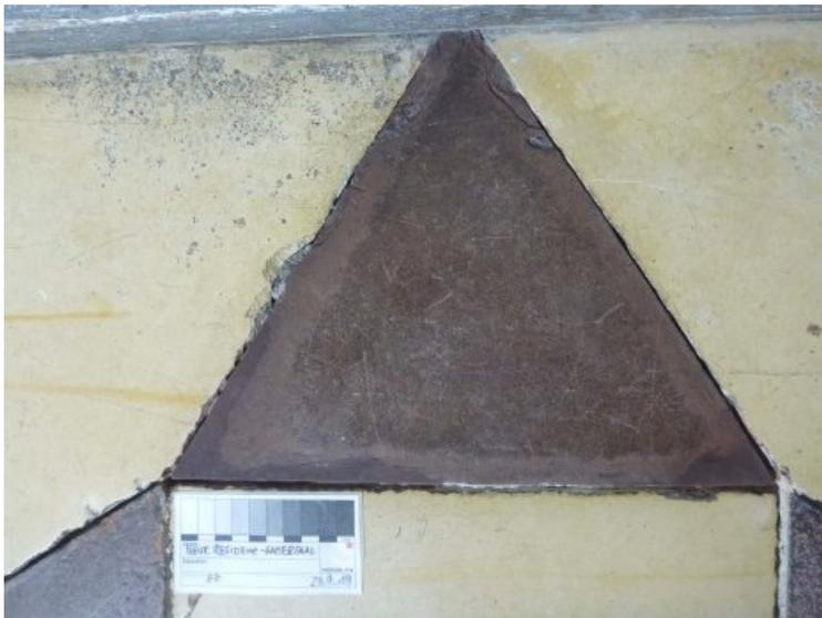
Die farbliche Angleichung und Imitation der Patinierung wurde mit Retuschen vorgenommen. Abschließend erfolgte eine Behandlung mit Wachs zur Vereinheitlichung der Wasseraufnahme und zur Reduzierung der Schmutzanfälligkeit.
