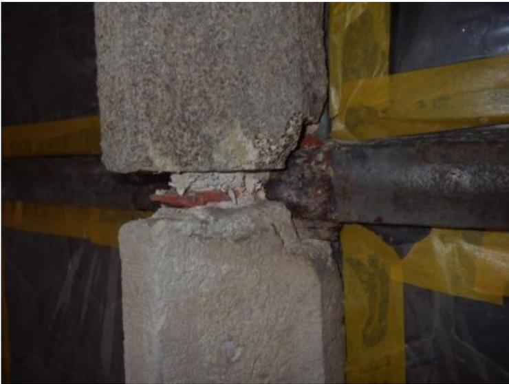
Die Altverfugung wurde unter Erhaltung der originalen Fugenflanken entfernt
