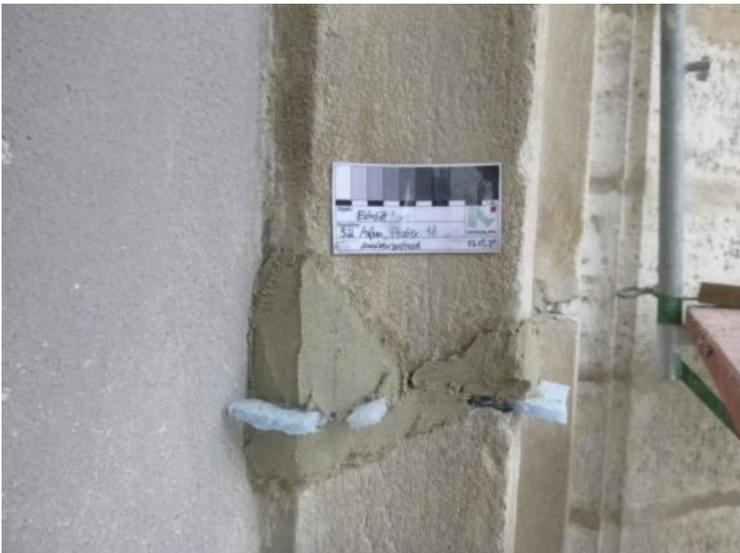
Rekonstruktion der Fugenflanken mit farblich angepasster Steingängzungsmasse
