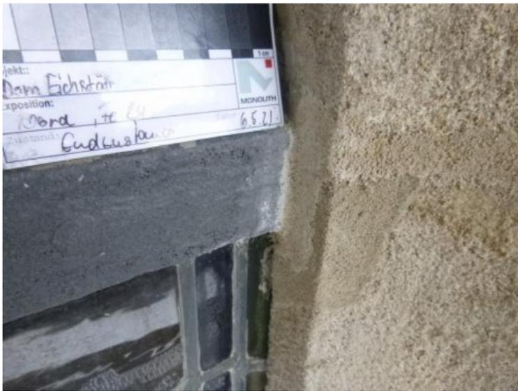
Die Metallteile wurden mit einer Rostschutzfarbe versehen und die Einbindestelle am Naturstein mit Steinergänzungsmasse verschlossen
