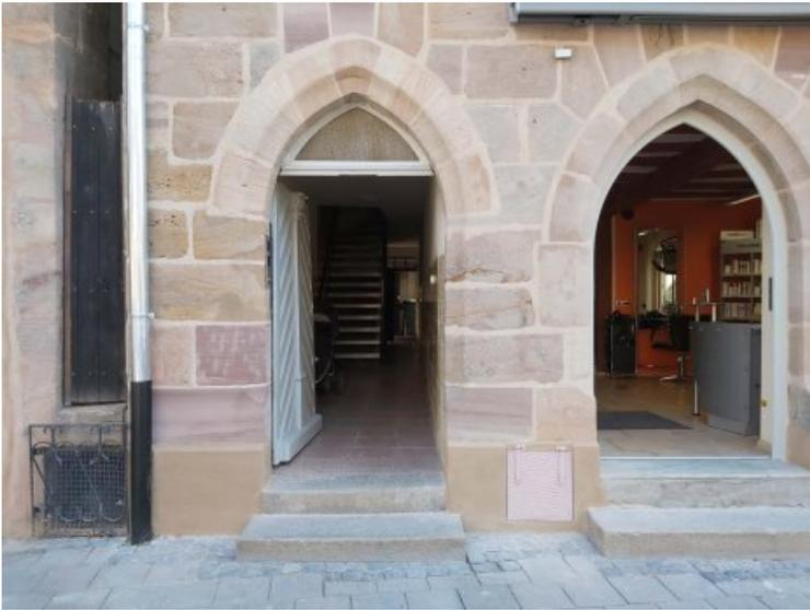
Salzspeicherputz wurde, dem Stein- und Fugenverlauf folgend, bis in 1 m Höhe (drei Steinlagen) aufgetragen.
