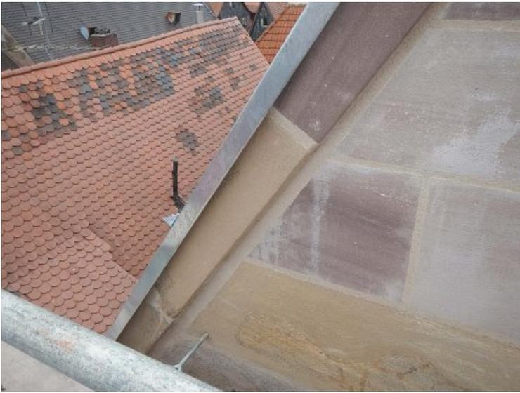
Desolater Stein wurde durch Neuteile ausgetauscht, verwitterte Steinoberflächen wurden gefestigt und durch Steinergänzungsmörtel ergänzt.
