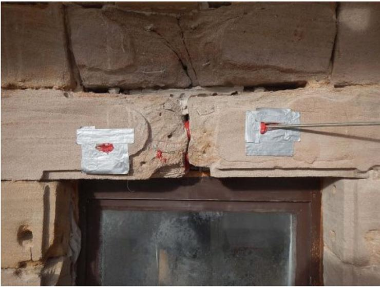
Gebrochene Werksteine (Detail Fenstersturz) wurden zur konstruktiven Sicherung mittel chemischer Dübel vernadelt.
