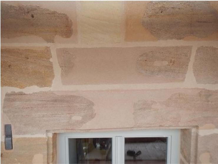
Risse wurden verschlossen, Fehlstellen, Bohrlöcher und Fugen durch passende Ersatzmassen ergänzt.
