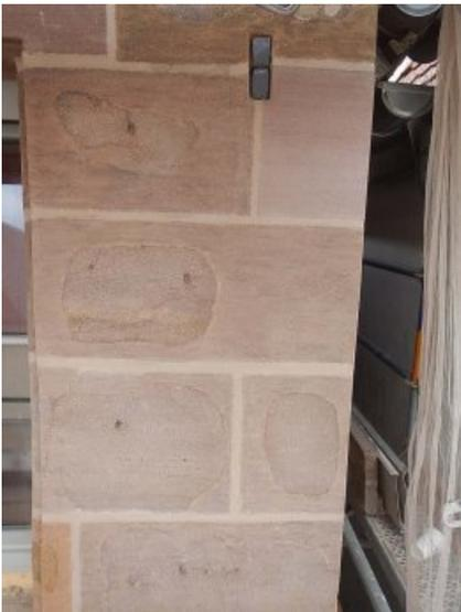
Intakte Bereiche wurden erhalten, die ausgearbeiteten Bereiche wurden durch an den Stein angepassten Steinersatzmörtel ergänzt.
