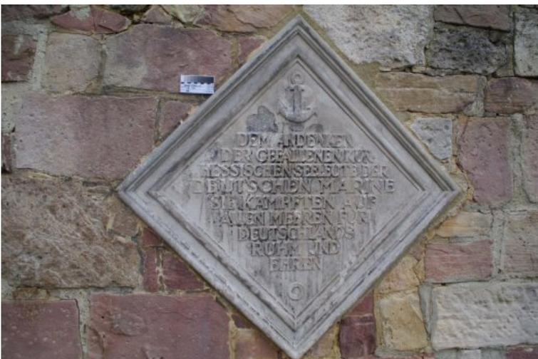
E4.3-E5.2\_A10\_EP01\_SW: Epitaph nach den durchgeführten Maßnahmen Reinigung, Sicherung Riss- und Schalen, Ergänzen mit Steinersatzmassen, Erneuerung defekter Altergänzungen sowie Fugen verschließen.
