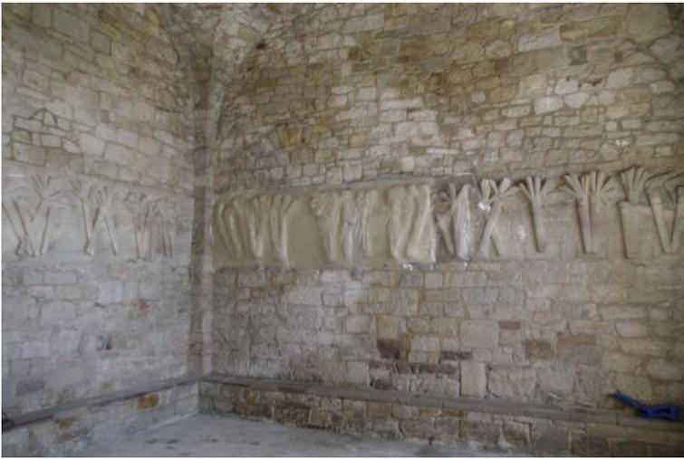
Detail Salzreduzierung: Diese wurde mittels trocknender, temporärer Kompressen durchgeführt. Bei ca. 50##PERCENT## der Oberfläche des Fackelfrieses wurde diese Maßnahme durchgeführt.
