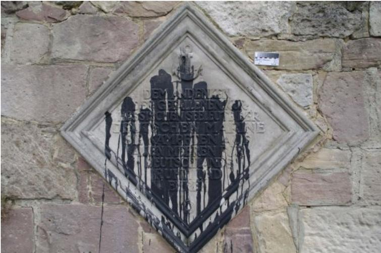
E4.3-E5.2\_A10\_EP01\_SW: Vor der Reinigung von Bitumenauflagen bzw. schwarzer Farbe.
