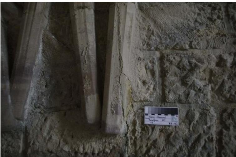
Detail Fackelfreis NO: Risse wurden injiziert und durch mineralischen Mörtel verschlämmt, die Oberfläche farblich durch Normalretusche an den Bestand angepasst.
