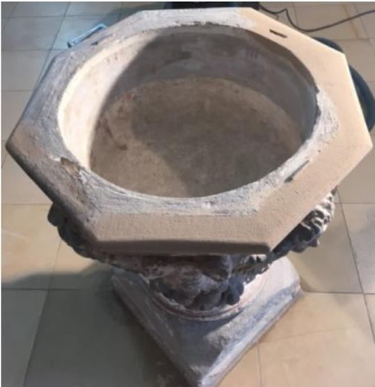
Die Gipsergänzungen wurden durch Ergänzungen aus Steinersatzmasse ausgetauscht. Nach Anziehen des Mörtels wurde die entstandene Sinterschicht entfernt. Hier noch vor dem Einbau der Abstandshalter aus Metall.
