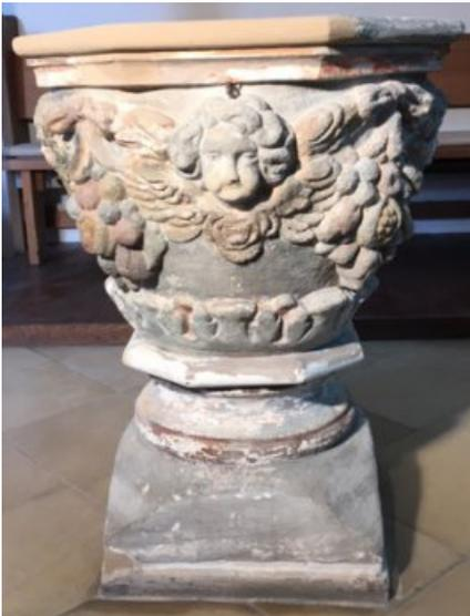
Fehlstellen am oberen Profil sowie an bildhauerischen Bereichen wurden mit Steinersatzmasse ergänzt. Dazu wurde Steinersatzmasse zunächst über Niveau angetragen.
