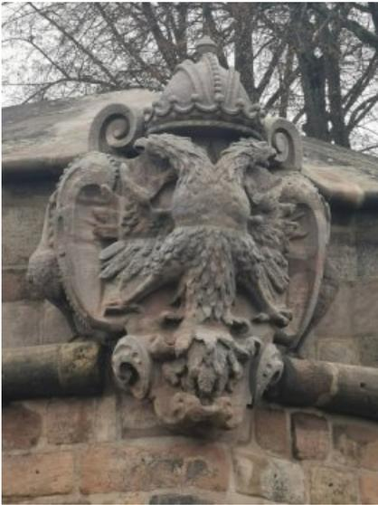
Durch eine Reinigung sowie die Erneuerung von Fugen und Ergänzungen ist das Wappen ästhetisch aufgewertet.
