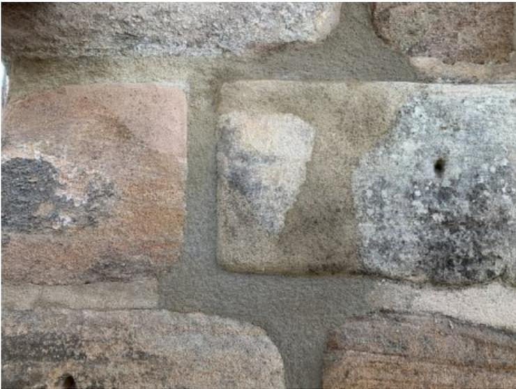
Die geöffneten Fugen und Fehlstellen im Mauerwerk wurden mit entsprechenden Mörteln verschlossen und fachgerecht nachbearbeitet.
