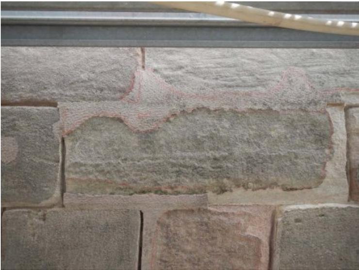
Detail von bereits ausgearbeiteten Fugen mit noch vorhandenen desolaten Altergänzungen.
