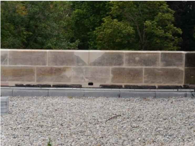
Detail zur Ergänzung und Neuverfugung der Mauerkrone im Endzustand.
