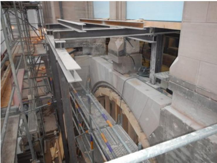
Nach dem Versetzen der Bogensteine lastet das darüber befindliche Mauerwerk wieder darauf.
