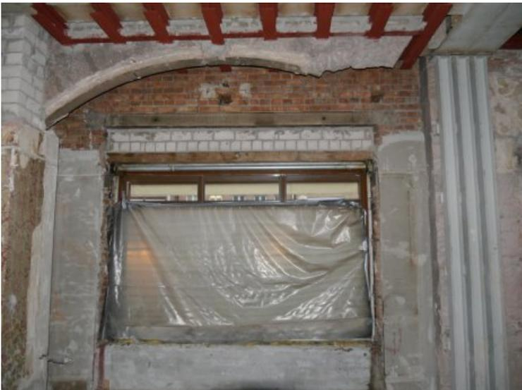
Der durch den Umbau stark beschädigte Bogen sollte rekonstruiert werden.
