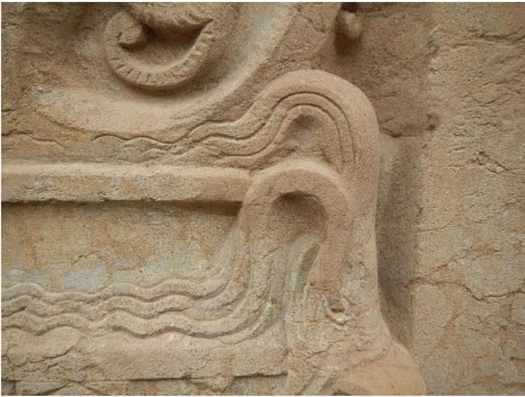
Nach der Ergänzung mit an den Bestand angepasste Steinersatzmasse.
