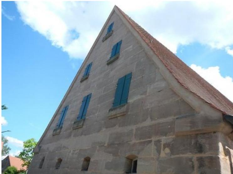
Die steinsichtige Fassade des Baudenkmals ist aus einem regelmäßiges Quadermauerwerk errichtet.
