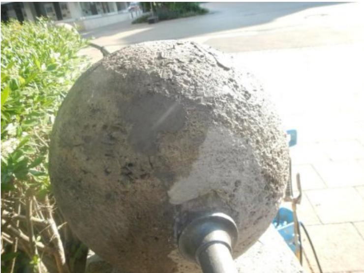
Die Einbindestelle wird mit Steingergänzungsmörtel verschlossen.
