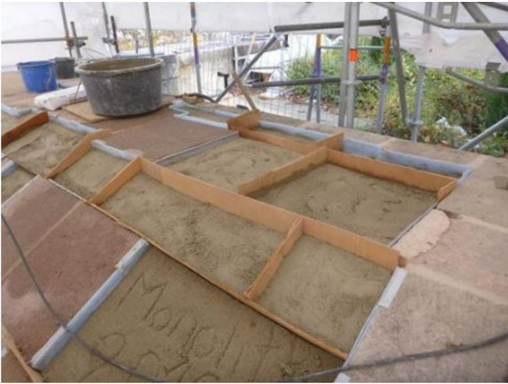
Während der Arbeiten an der Mauerkrone: In Situ wurden Ortbetonteile neu angetragen.
