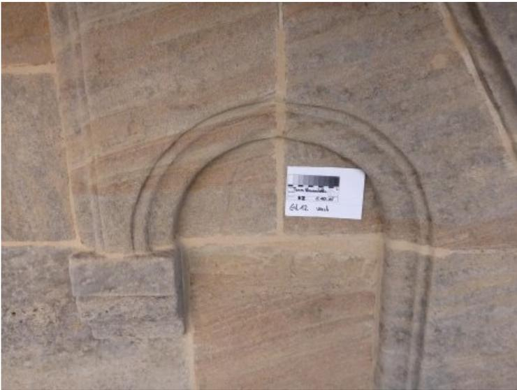
Das Mauerwerk nach Reinigung, Fugensanierung und Ergänzung von Fehlstellen.
