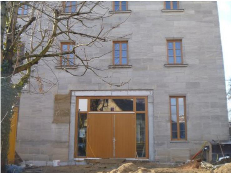
Die Nordfassade kurz vor Abschluss der Maßnahme. Eine Tür wurde eingebaut, Fensteröffnungen erweitert und eine Fensteröffnung geschlossen. Neuteile und Fugen haben hier eine dunklere Farbigekeit, da sie noch nass sind.
