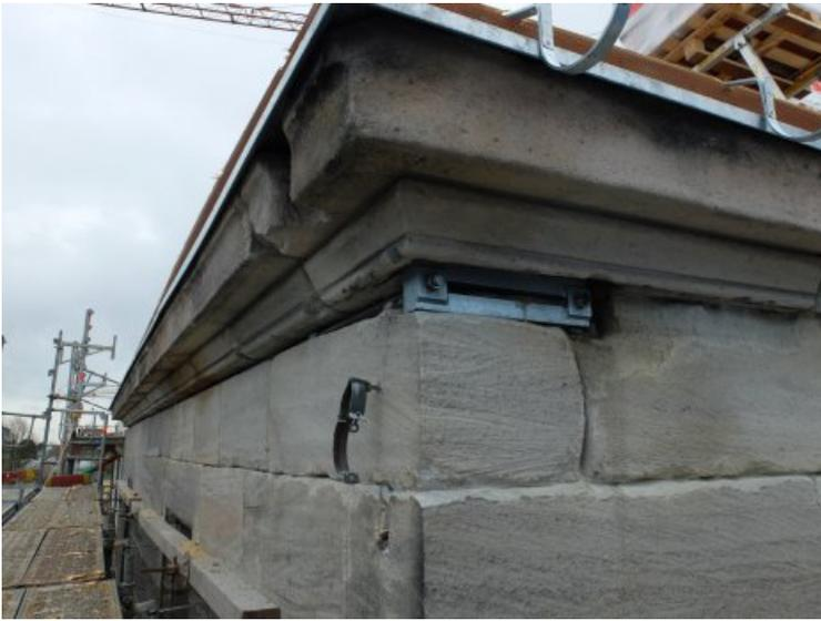
Zur Stabilisierung des Gebäudes wurden Doppel-Zuganker in die Mauerkrone auf der Ost- und Westseite eingebaut.
