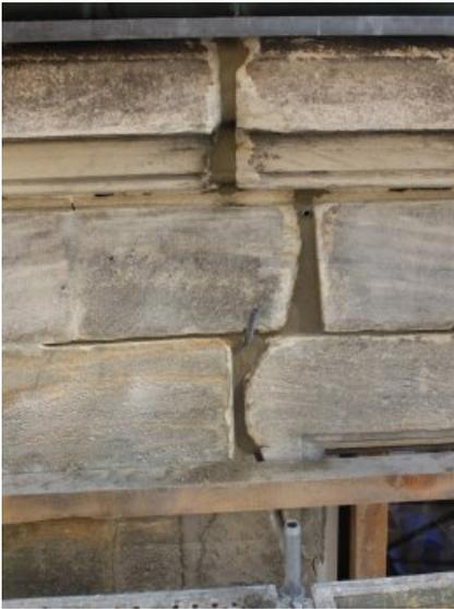
Aufgrund von Veränderungen der Gebäudestatik entstandene tiefe Fugen wurden vorverfügt. Zum Verpressen wurden Packer in den Vorverfugungsmörtel eingesetzt.
