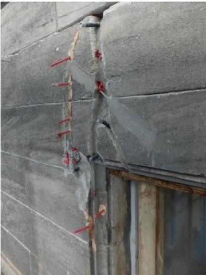
Durch statische Veränderung entstandene Risse in Werksteinen wurden mit Kunstharz injiziert. Dazu wurde der Riss temporär mit Ton abgedichtet.
