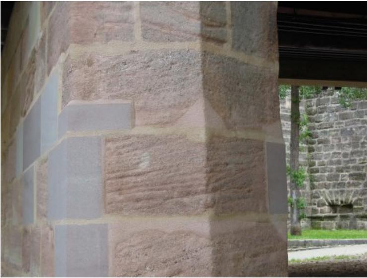
Fehlstellen wurden mit einer sowohl in Körnung und Farbigkeit als auch physikalisch und feuchtetechnischen Eigenschaften passender Steinersatzmasse zum Originalmaterial gegänzt. Eine mineralische abbindende Masse wurde für den Verschluss in den Sandsteinen verwendet.
