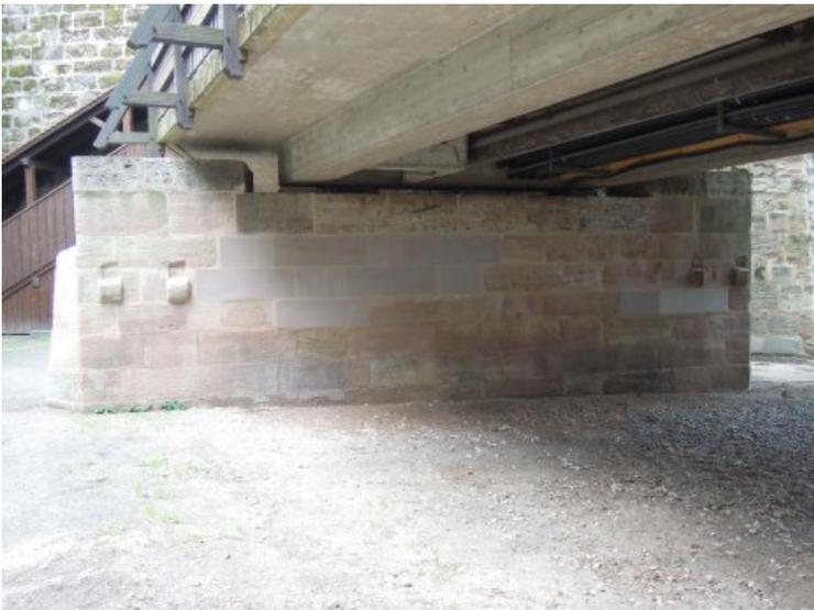
Zum Ersetzen stark reduzierter Bauteile und Bauteilbereiche wurden Neuteile, Verblender und Vierungen in Maß und Form entsprechend dem Bestand eingebaut.
