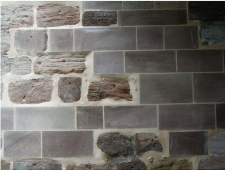
Stark reduzierte Bauteile wurden durch Neuteile ausgetauscht. Wo möglich, wurde Originalsubstanz erhalten und konservativ, durch Anböschen, Schlämmen und Ergänzen, behandelt.
