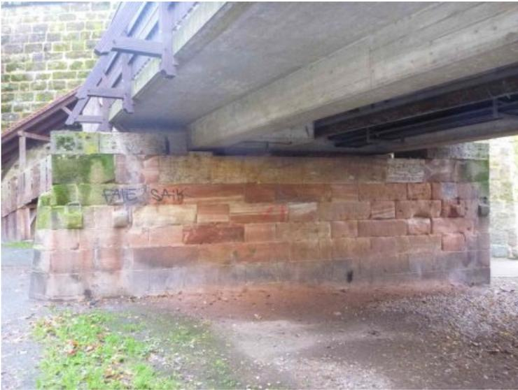
Vor der Reinigung sind der biogene Bewuch sowie Graffiti sichtbar. Durch Verwitterung und Salzbelastung geschädigtes Mauerwerk vor der Überarbeitung.
