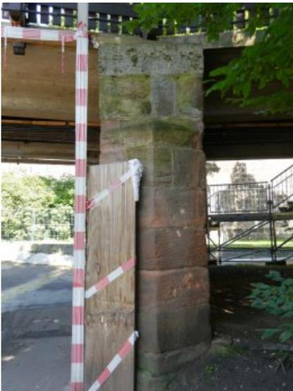
Die Reinigung der Mauerflächen von Schmutz sowie Biogener Bewuchs erfolgt mittels Hochdruckreiniger.
