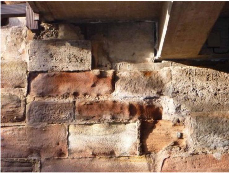
Detail von stark verwitterten Werksteinen mit entfestigten Sandsteinbereichen sowie Kantenverlust.
