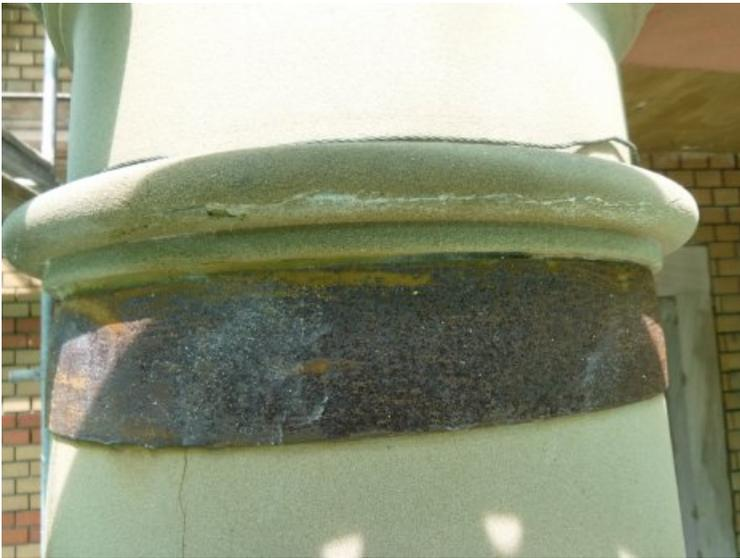
Die Risse wurden mit einem besonders fließfähigen Mörtel verfüllt. Anschließend konnten die Fehlstellen mit Steinersatzmörtel ergänzt werden.
