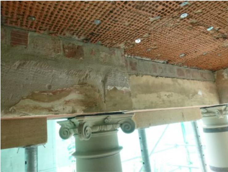
Balkonundersicht nach Sicherung / Erneuerung der Unterkonstruktion. In Vorbereitung des Neuperputzes wurde die Fläche mit Ziegelgewebe versehen.
