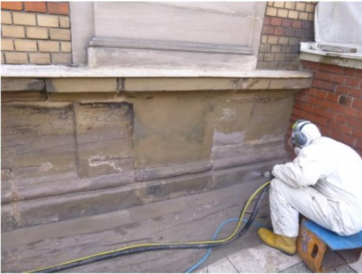
Entfernung der abdichtenden Beschichtung am Sockel mit Hilfe des Rotationswirbelstrahlverfahrens.
