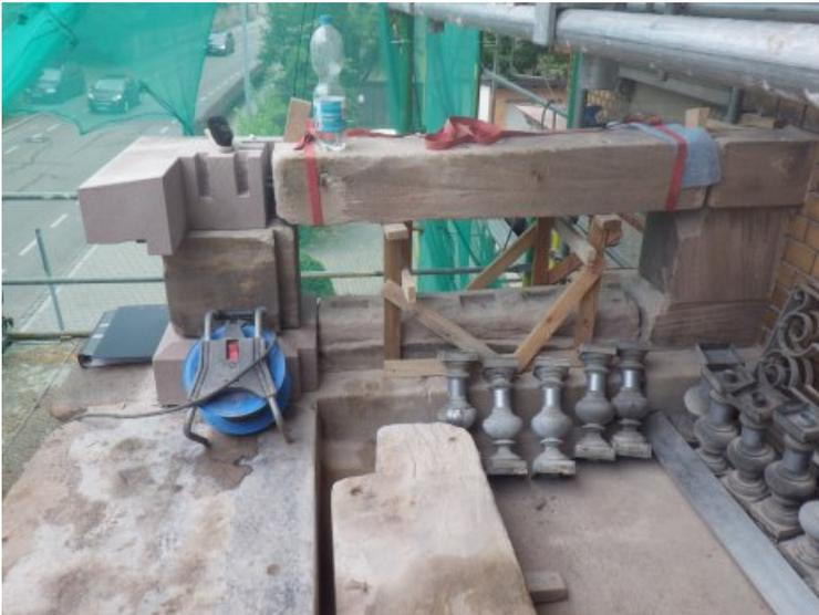
Abbau der Balkonbrüstung, Einbau von Neuteilen, statische Sicherung nach Vorgabe von IB Trafektum.
