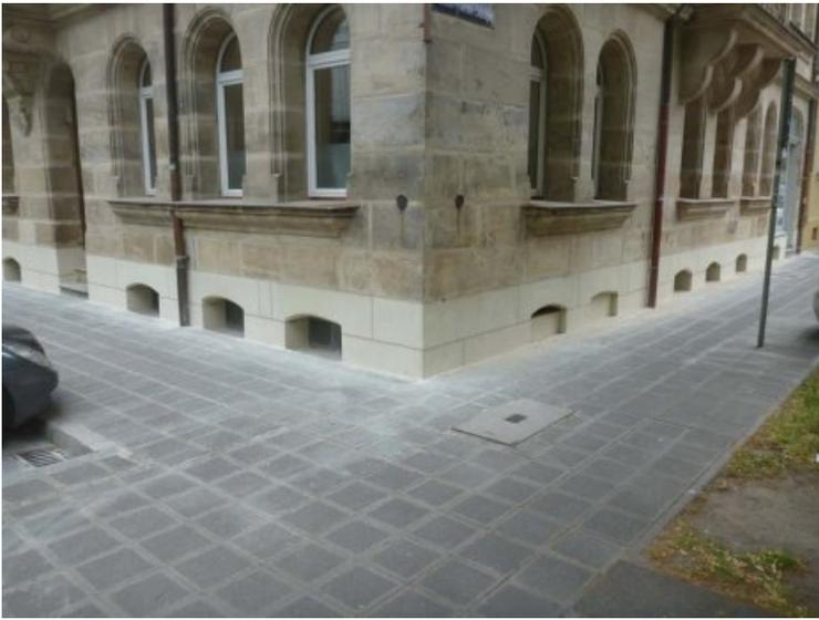
Endzustand des Sockels. Der angetragenen Salzspeicherputz wurde überarbeitet und farblich an die Originalsubstanz angepasst.
