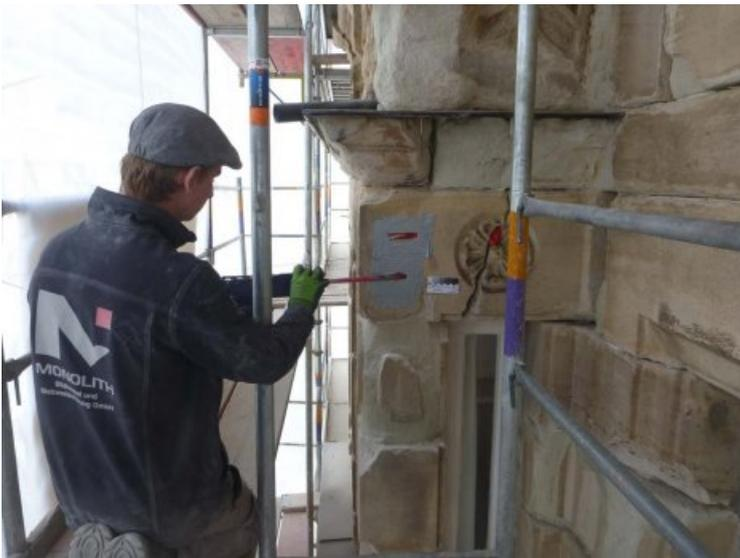
Zur Sicherung der Stürze wurden Nadeln eingeklebt.
