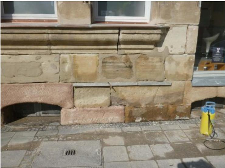
Nach Ausarbeitung und Reduzierung bauschädlicher Salze erfolgten Ergänzungen im Bereiche der 3 Gesteinslage im Sockelbereich.
