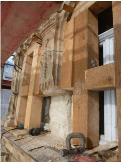
Beim Austausch der Gewändesteine wurden Holzbalken als Stützen eingesetzt.
