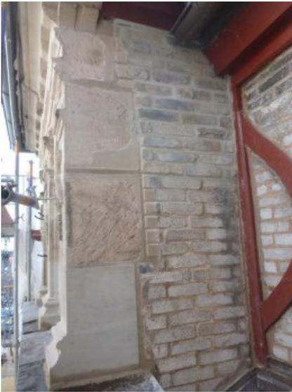
Fehlstellen, offene Fugen, große Abrisse und stark gelockerte Bereiche wurden geschlossen bzw. wiederausgebaut und -aufgemauert.
