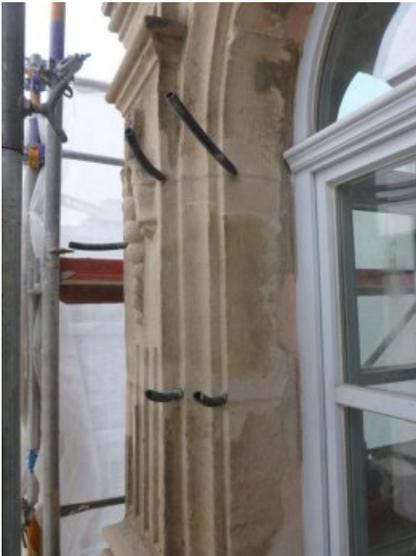
Mittels Packer wurde Verpressmörtelsuspension injiziert.
