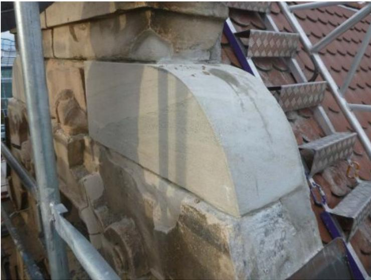
Austausch und Einbau der Neuteile erfolgte mit Hilfe eines Krans. Darüber befindliche Steine wurde ab- und wiedereingebaut.
