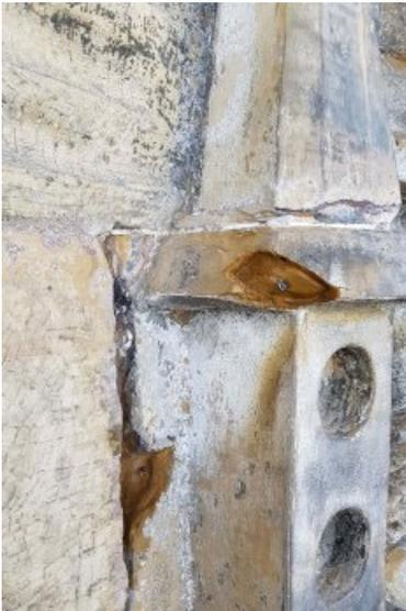
Die zuvor gefestigten Bereiche wurden vor dem Antrag des Ergänzungsmörtels mit einem Draht armiert.
