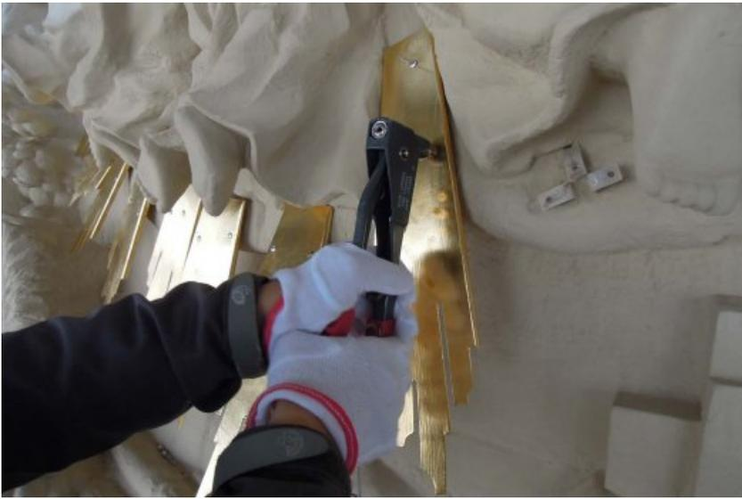
Die blattvergoldeten Metallelemente wurden teils mittels Schrauben, teils mittels Nieten remontiert.
