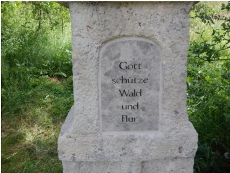
Endzustand: Im Sockel wurde eine neue Schriftplatte aus Kleinziegenfelder Dolomit eingesetzt.
