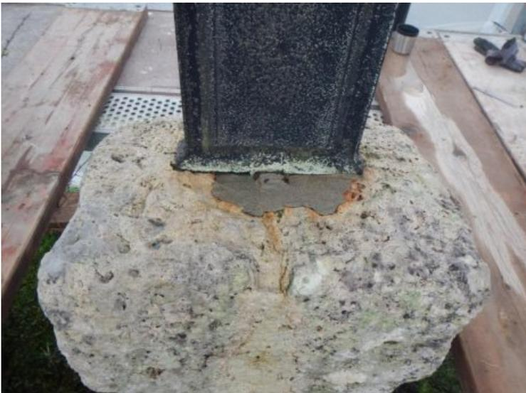
Nach der Reinigung sind Schäden auf der Natursteinoberfläche erkennbar. Risse und Fehlstellen zeigen sich ringsum die Einbindestelle des Kreuzes.
