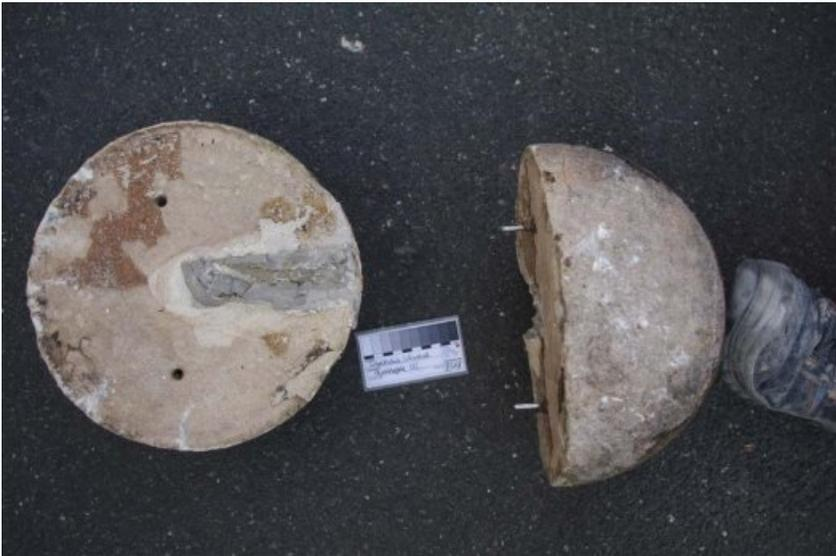
Reinigen der Kugel, Wiederverdübeln und kraftschlüssiges Verkleben vor der Wiederanbringung.
