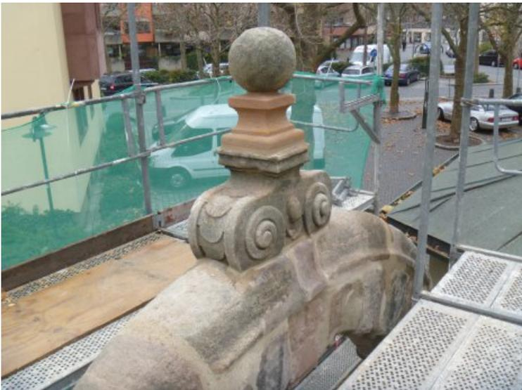
Das Profilstück der Torbogenbekrönung wurde durch ein Neuteil ausgetauscht.
