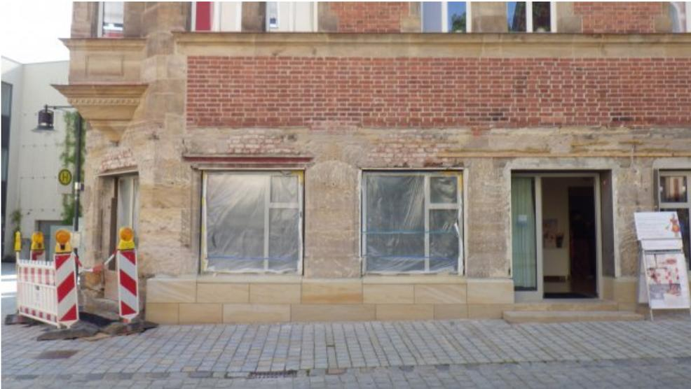
Das Sockelmauerwerk wurde mit Sandsteinplatten verblendet.
