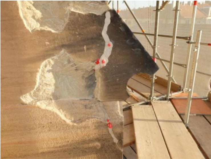
Arbeitsfoto: Nach dem Ausarbeiten der Altergängerung, während einer Risschließung.
