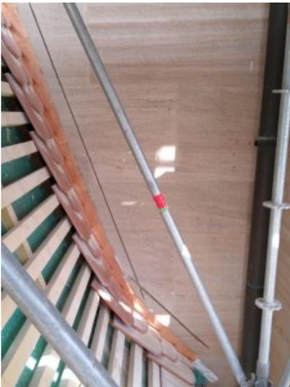
Zur Anbringung der Verblechung wurde parallel zur Dachoberfläche eine Nut gefräst.
