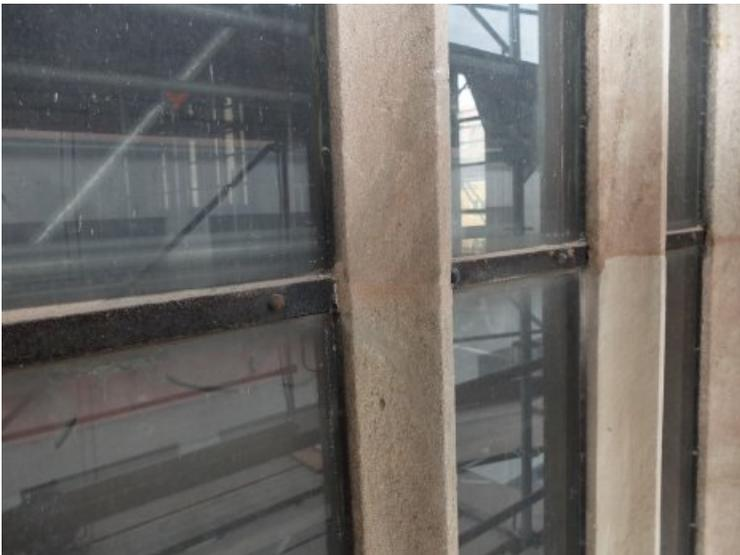
Nachzustand: Abschließend wurde der Riss oberflächlich verschlossen.
