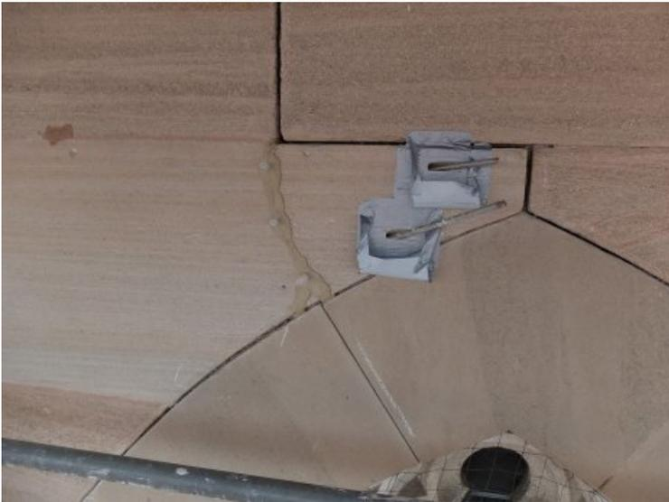
Arbeitsfoto: Für die Vernadelungen wurden Bohrungen senkrecht zum Riss gesetzt und Gewindestäbe eingesetzt.
