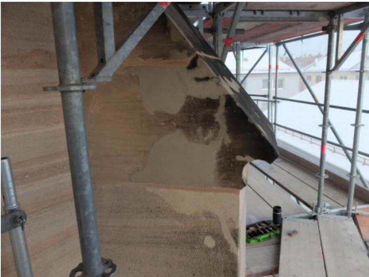
Nachzustand: Die Ergänzung wurde über Oberflächenniveau angetragen und vor zu schnellem Austrocknen geschützt. Nach Erstarren der Masse wurde die Sinterschicht entfernt und die Oberfläche auf Umgebungsniveau angearbeitet.
