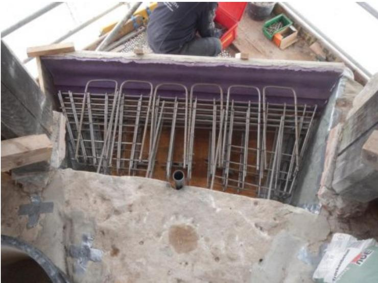
Ein Schalkorb und der Einsatz von Bewehrungsstahl bildeten die Grundlage für eine angepasste Betonergänzung.
