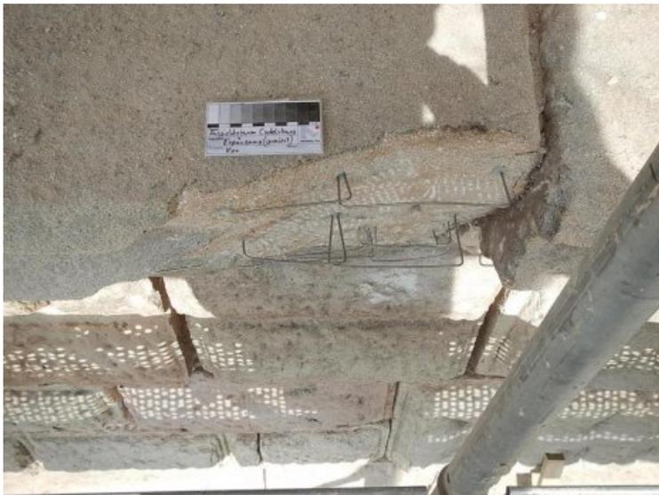
Für die Ergänzung mit Steinersatzmassen werden die Flächen nach Bedarf mit Armierungen versehen.
