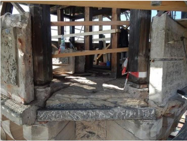
Einige Werksteine der Aussichtsplattform wurden abgebaut, das schadhafte Material wurde zurückgearbeitet.
