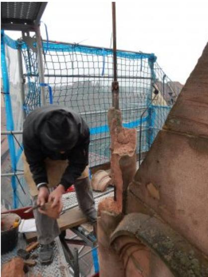
Beim Abbau eines stark entfestigten fialähnlichen Ausatzes.
