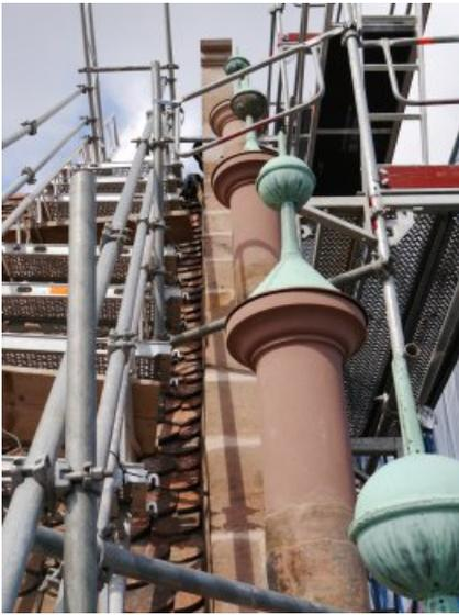
Nach dem Versetzen der Neuteile der fialähnlichen Aufsätzen auf den Giebelschrägen inklusive des Verdübelns dieser. Bauseits wurden die Hauben wiederbefestigt.
