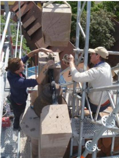
Beim Wiederversetzen wurden die Werksteine des Aufsatzes durch Dübel verbunden. Das Versetzen erfolgte mit dem Teleskop-Autokran.
