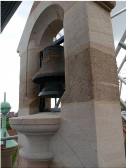
Nach Wiederaufbau des Glockenaufsatzes unter Verwendung von Bestandsmaterial und Einbau von Neuteilen.
