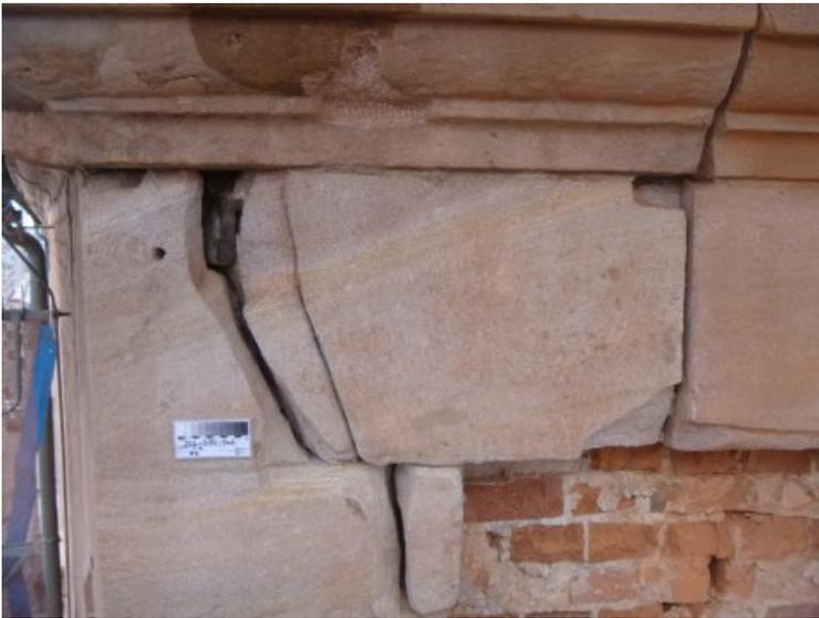
Da an der Nordostecke starke Schäden und Risse im Mauerwerk zu verzeichnen waren, wurden hier Neuteile eingebaut.
