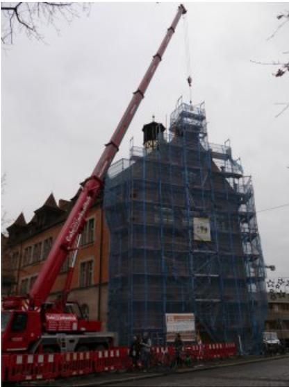
Beim Abbau des Glockenaufsatzes mit dem Teleskop-Autokran.
