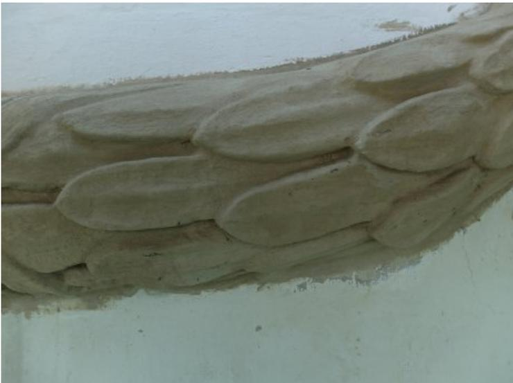
Oberflächiger Rissverschluss und Verschlämmen der Oberfläche
