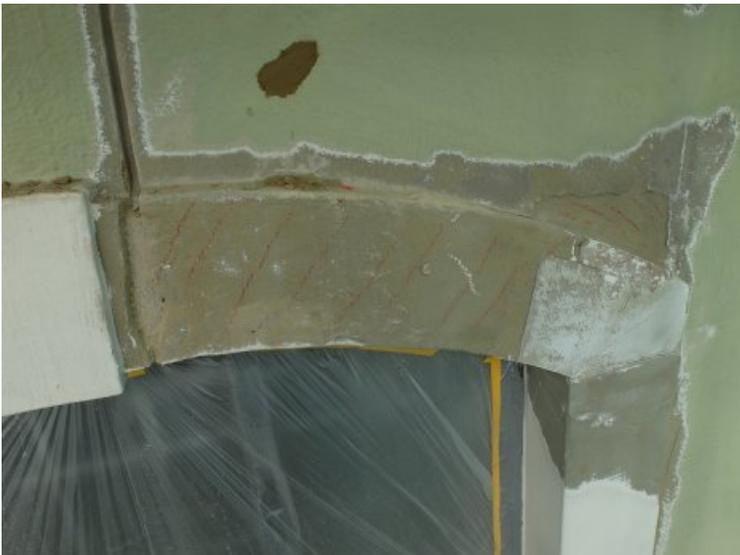
Stark reduzierte Werksteine werden durch Neuteile ersetzt
