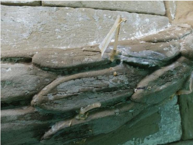
Rissinjektion mit farblich angepassten Mörteln über Kanülen
