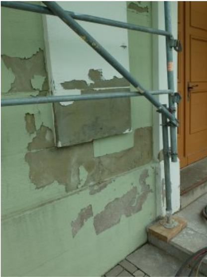
Erfolgt Austausch durch Neuteile unter Beibehalten des ursprünglichen Fugenschnittes
