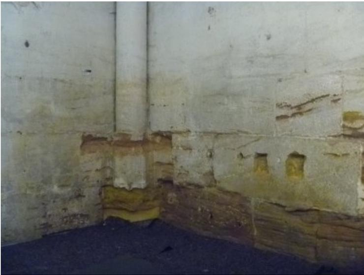
Durch Kristallisations- und Lösungsprozesse bauschädlicher Salze Schäden entstandene Schäden im Sockelbereich.
