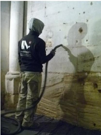
Oberflächliche Salze werden mittels Staubsauger entfernt. Zum Schutz der Bodenplatten abdecken mit Matten.
