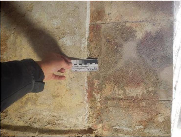
Die eingebrachten Ergänzungen wurden in Form und Farbe an die umliegende Substanz angeglichen.
