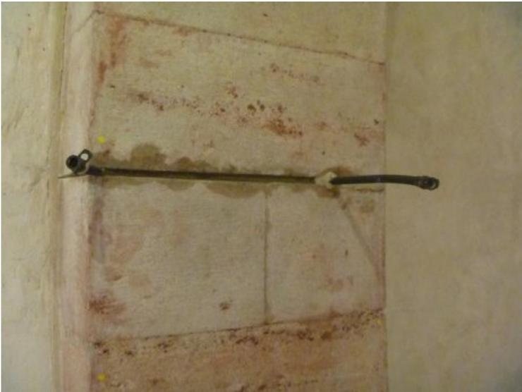
Tiefe Fugen wurden mittels Schläuchen und Packern kraftschlüssig verpresst.
