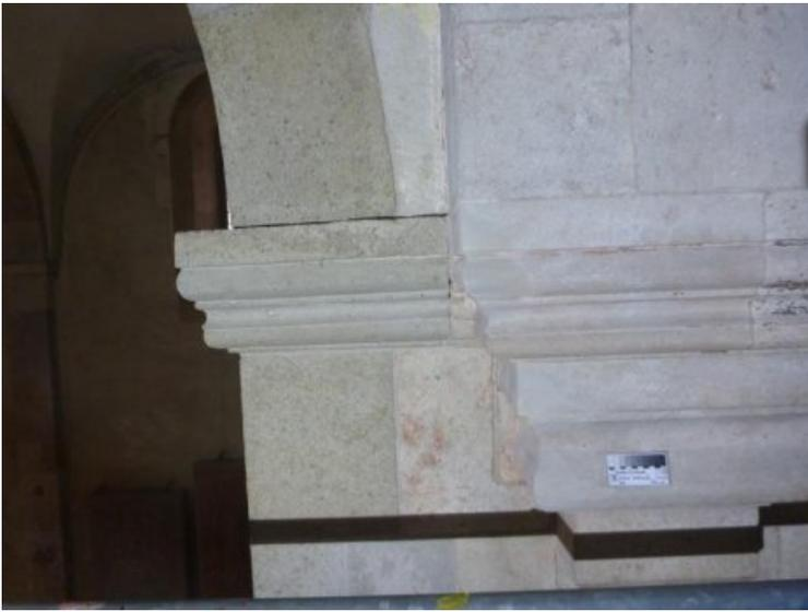
Neuteile wurden nach historischem Vorbild angefertigt und passgenau in den Bestand eingesetzt.
