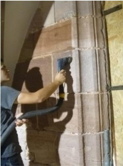
Während der Reinigung mit dem Vakuumwaschsauger.
