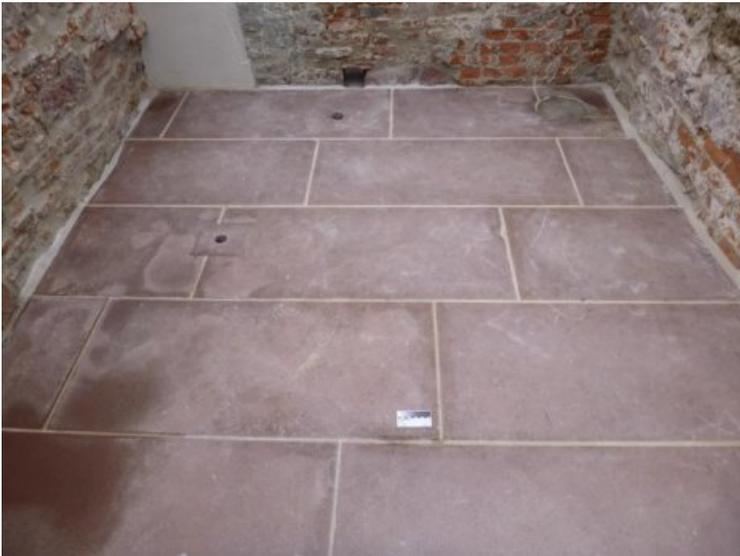
Die Fugen der Bodenplatten wurden mit einem porenhydrophoben Mörtel ergänzt
