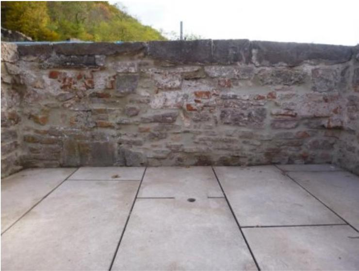
Die Altverfugung der Bodenplatten wurde entfernt
