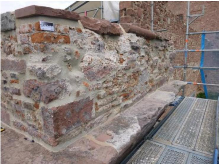
Ein einheitliches Fugenbild gewährleistet den Wasserablauf und verhindert den Eintrag von Feuchtigkeit
