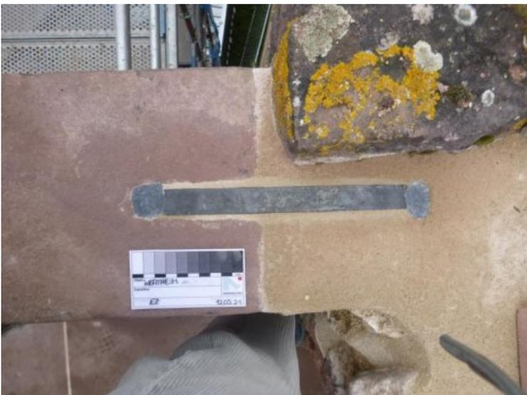
Die neu eingesetzte Bauklammer wurde fachgerecht verbleibt und in den Bestand eingebunden
