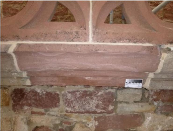
Durch Reinigung, Fehlstellenergänzung und Neuverfugung erfolgte eine ästhetische Aufwertung
