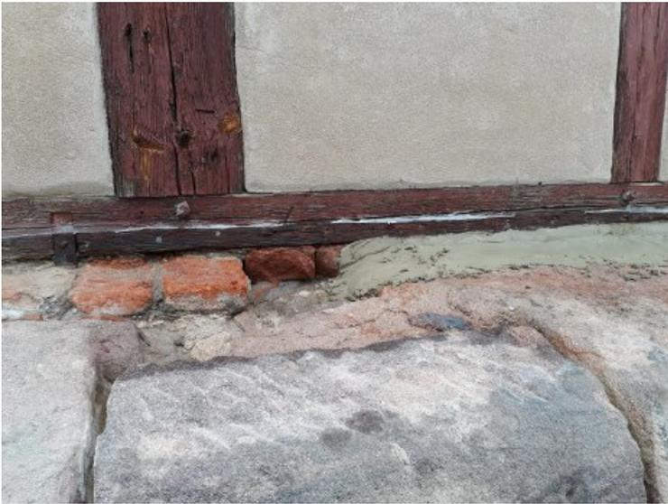
Große Zwischenräume wurden mit Ziegel ausgewickelt, die Mauerkrone schräg zulaufend verputzt; ZWISCHENZUSTAND
