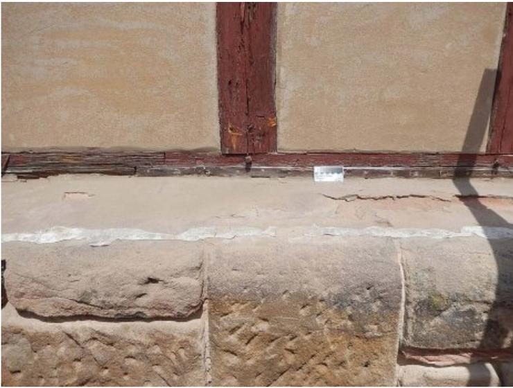
Die Mauerkrone wurde restauriert, neu verputzt und zur Gewährleistung des Wasserablaufes durch Mörtelkeil verputzt; ZWISCHENZUSTAND
