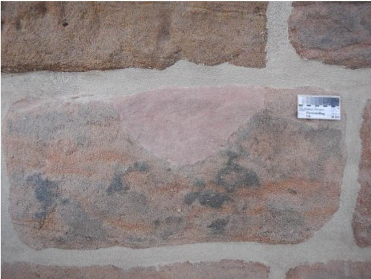
Defekte Fugen wurden entfernt und durch Fugenmörtel ausgetauscht, Fehlstellen ergänzt, Schalen gesichert oder entfernt und schwarze Krusten reduziert; NACHZUSTAND
