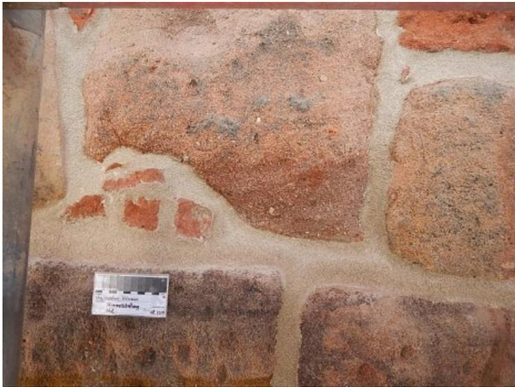
Defekte Ziegelauszwickungen wurden neu verfugt, partiell wurden defekte Ziegel ausgetauscht, Fugen abschließend mit angepasstem Fugenmörtel verschlossen; NACHZUSTAND
