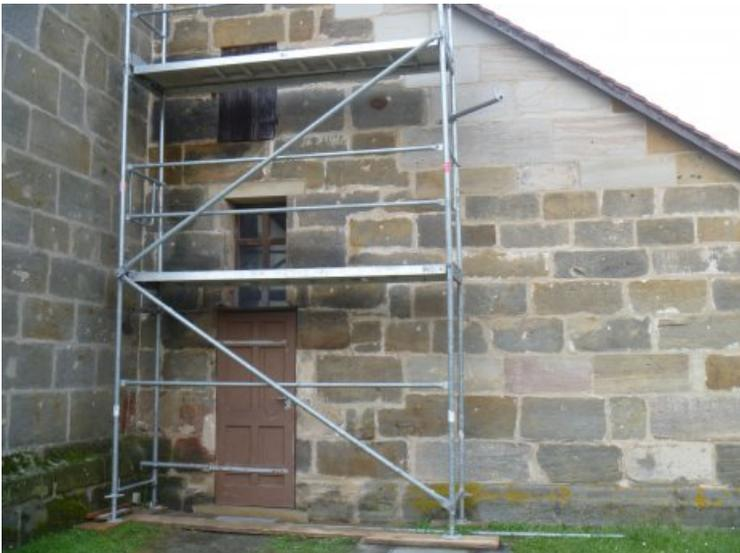
Das Außenmauerwerk der Sakristei nach der Restaurierung. Der Sturz wurde durch eine Neuteil ersetzt.
