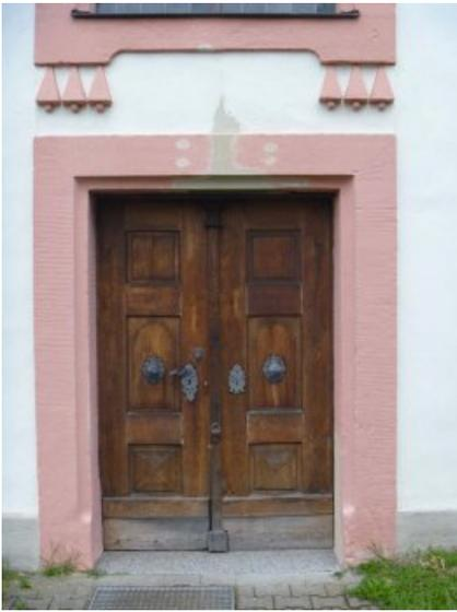
Nach dem Ergänzen von Laibung und Sturzes. Die Wiederherstellung der Beschichtung erfolgt bauseits.
