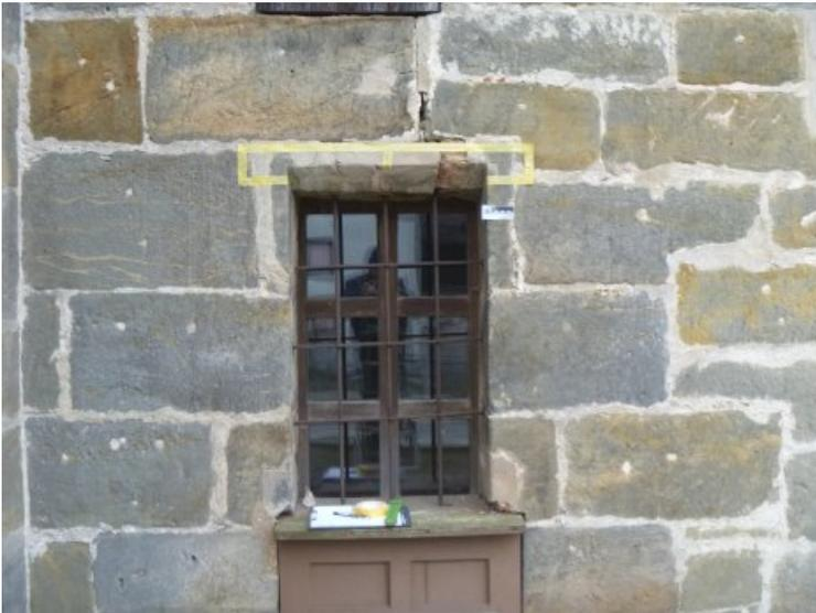
Durch bauliche Veränderungen bilden sich im Mauerwerk Risse. Der Sturz kann die Last des darüber befindlichen Mauerwerks nicht aufnehmen.
