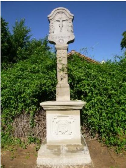
Bildstock am Guldenberg nach Reinigung, partieller Festigung, Riss- und Schalenbearbeitung sowie bildhauerischer Kopie des Reliefs und steinmetzmäßiger Herstellung des neuen Sockels.
