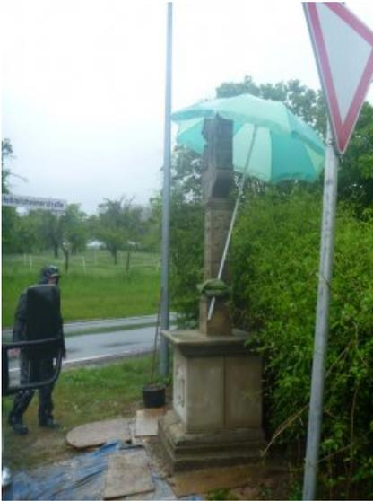
?und der Sockel mit Pfeilerschaft und Kreuzigungsaufsatz neu gesetzt. Fugen zwischen den Bauteilen wurden mit angepasstem Fugenmörtel geschlossen.
