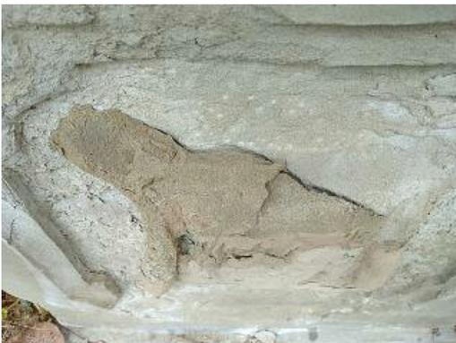
Sockel mit Schweißstuchdarstellung, stark zurückgewitterte und fragile Oberfläche. Oberflächenparallele Ablösung des Kopfes Christi.
