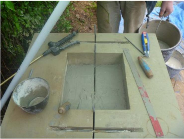
Der Sockel, bestehen aus Vorder- und Hinterteil, wurde in der Werkstatt kopiert und bildhauerisch neu gearbeitet. Nach Rücktransport wurde das Fundament neu ausgehoben?
