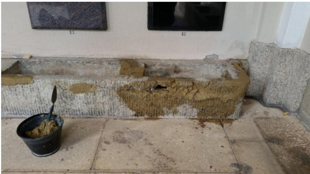
Zwischenzustand: Detail vom Ergänzungsprozess und Rissverschluss eines Blumenkübels mit mineralischer Ersatzmasse.
