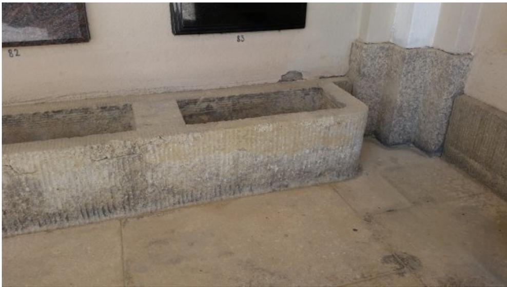
Zwischenzustand: Betonkübel nach Überarbeitung der Mörtelergänzung.
