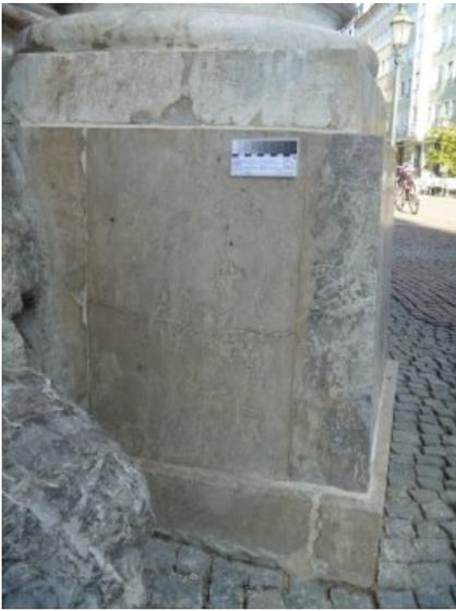
Bereich nach Reinigung, Ergänzung, Risschließung, Fugenbearbeitung und farbliche Anpassung durch Retusche.
