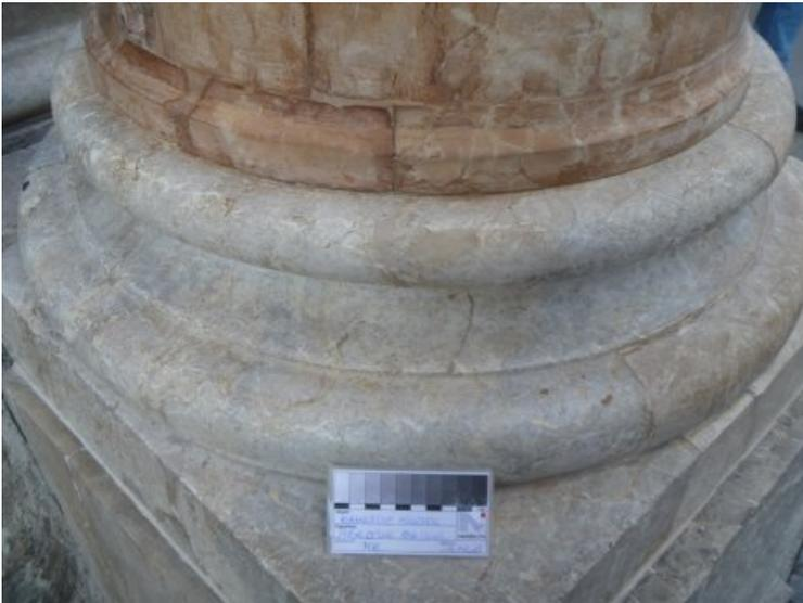
Detail der Säulenbasis mit ausgetauschter, in Farbigkeit und Eigenschaften an den Kalkstein angepasster Ergänzungsmasse und Schlämme zum Verschluss der Flankenabrissse des Fugenmörtels.
