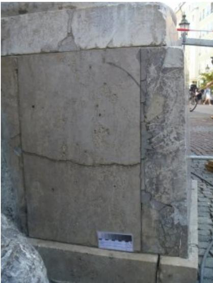
Das Postament weist defekte Altergänzungen, Abbrüche sowie desolate Fugen und offene Risse auf.
