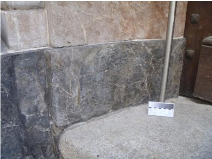
Der Mörtel wurde nach Abbinden überarbeitet, auf Oberflächenniveau angearbeitet und farblich angepasst.
