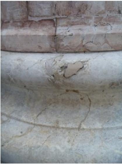
Detail der Säulenbasis mit defekter Altergänzung und defektem, aber stabil liegendem Fugenmörtel.
