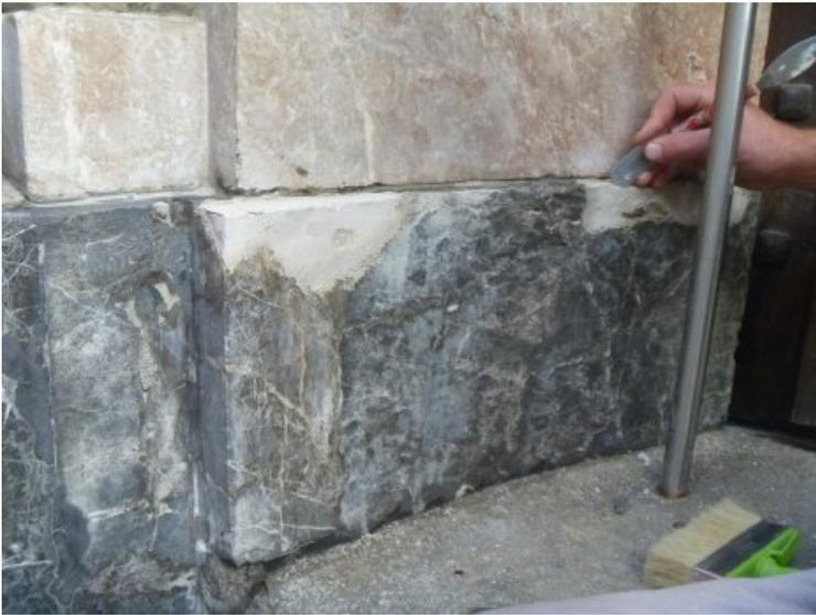
Größere Fehstellen am Sockel im Bereich der Tür wurden gereinigt und mit passendem Steinersatzmörtel ergänzt.
