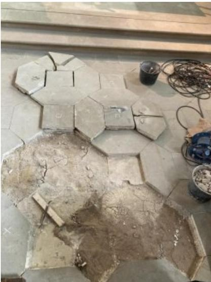
Zwischenzustand: Die Platten werden sorgsam ausgebaut und entsprechend dem Verlegemuster beschriftet.
