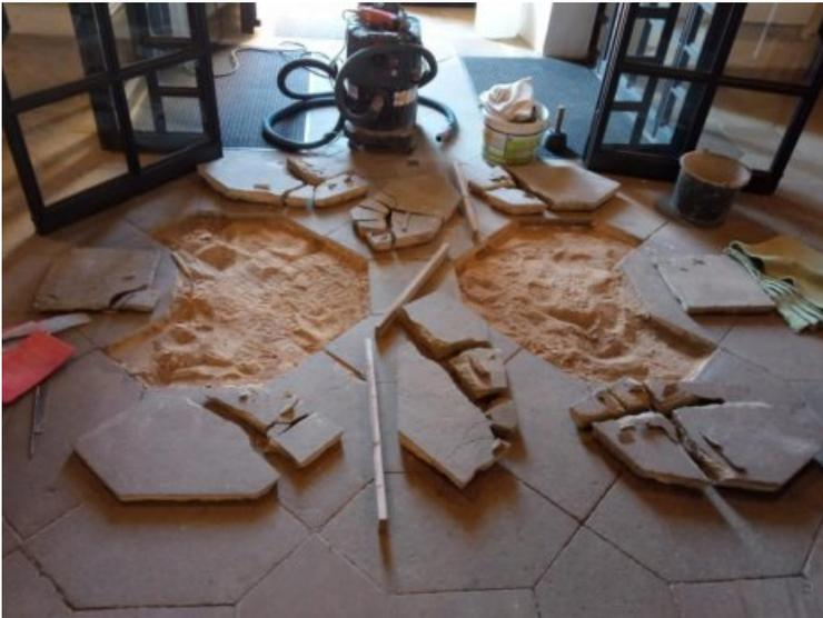
Zwischenzustand: Der Untergrund wurde mit Kies aufgefüllt, wodurch das Niveau wieder dem umliegenden Bestand entspricht.
