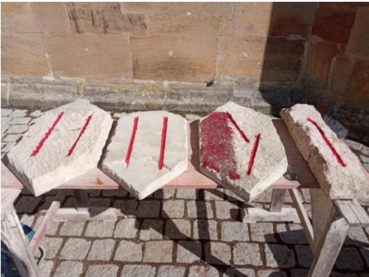
Zwischenzustand: Die gebrochenen Steine wurden verklebt und mit Gewindestäben stabilisiert.
