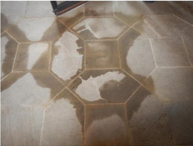
Zwischenzustand: Neuverfugung nach Wiedereinbau mit einem geeigneten Mörtel
