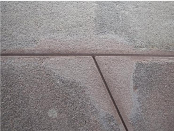
Wegen Befunden bei der Freilegung der Fassade im EG, die mit Sandsteinplatten verblendet worden war, erfolgte die Herstellung von Schattenfugen an der gesamten Fassade.
