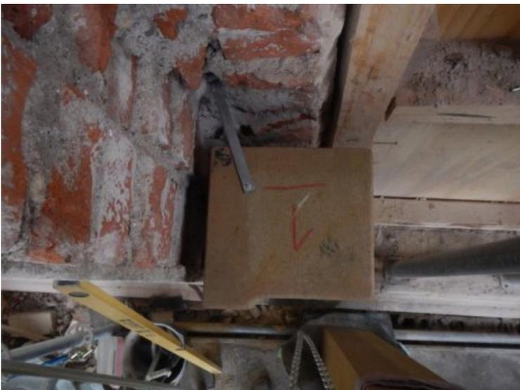
Sicherung eines Neuteils über Rückverankerung ins Mauerwerk
