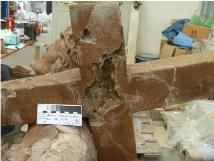
Defekte Altergänzungen wurden ausgearbeitet und die Fehlstellen anschließend ergänzt.
