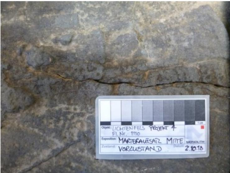
Vorzustand: Weiterer Riss im Aufsatz, verursacht durch einen korrodierten Metallhorn im Aufsatz.
