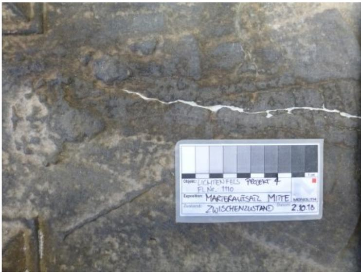
Zwischenzustand: Mineralische Masse wurde injiziert, anschließend der Riss auch oberflächlich verschlossen.
