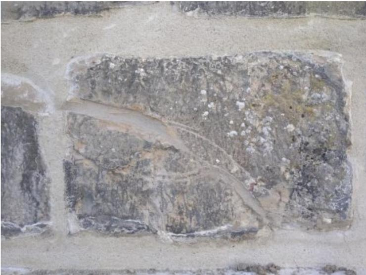
Endzustand Risse wurden verpresst und oberflächlich mit mineralischem Mörtel ergänzt.
