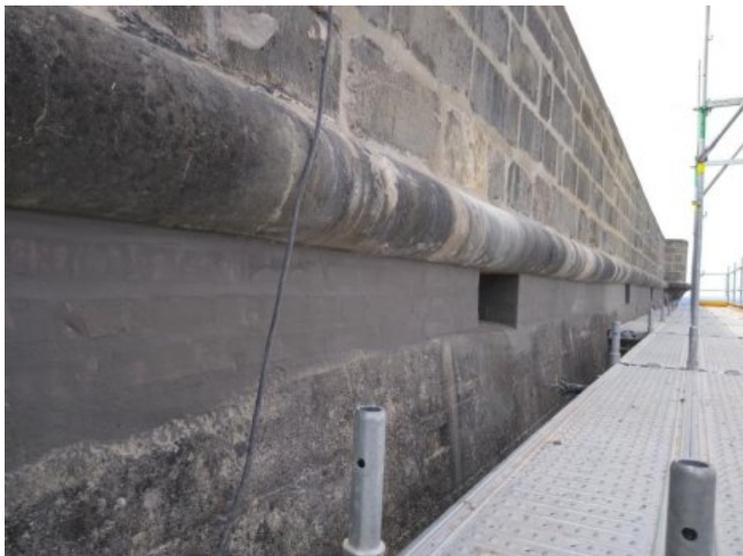
Endzustand Die Aufmauerung wurde farblich passend überputzt, Fugen wurden erneuert und Risse verschlossen.
